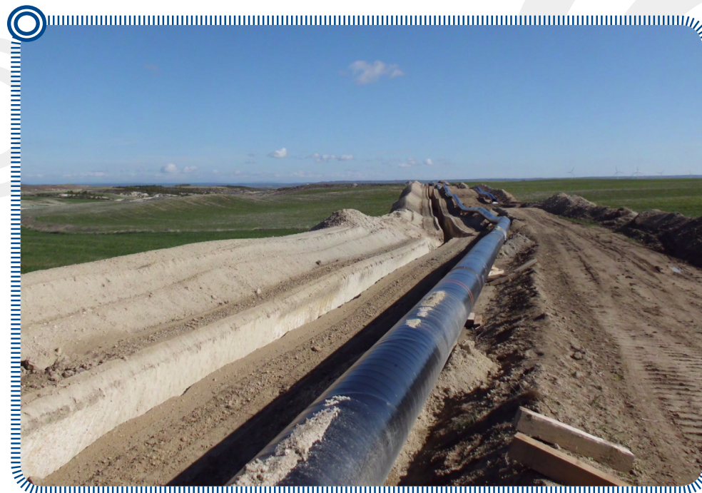
Gasoducto Yela-Villar de Arnedo
