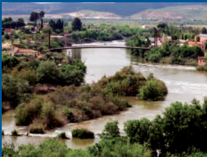
Pasarela sobre el río Tajo. Urbanización Parque Solanilla. Toledo
