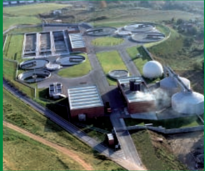
Depuradora de Sabadell (SPA). Barcelona
