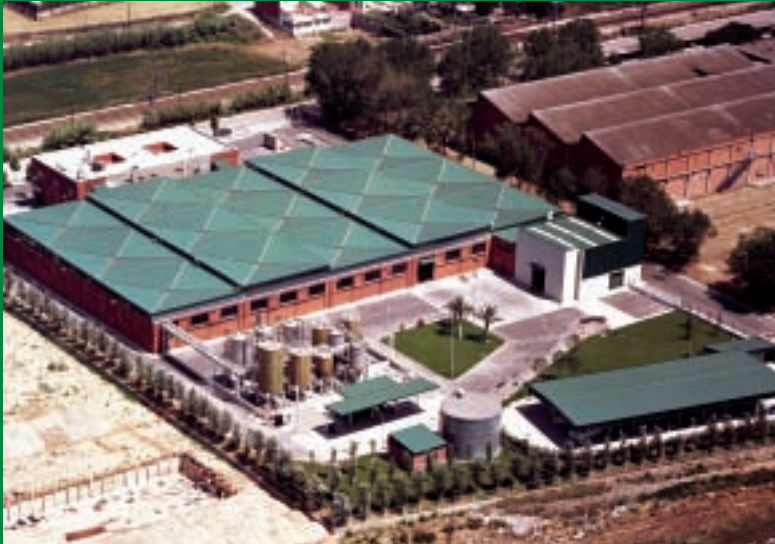
Planta de transferencia de Montmeló. Barcelona
