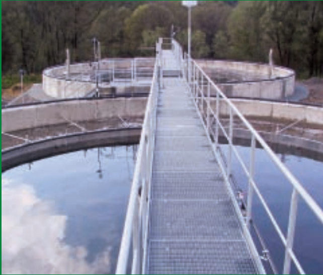
Depuradora de aguas residuales de Jablunkov. República Checa
