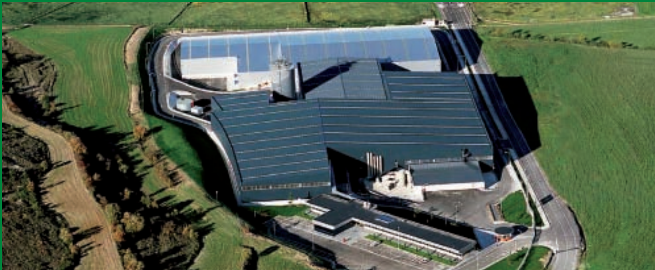
Planta de tratamiento de residuos. Jundiz. Vitoria
