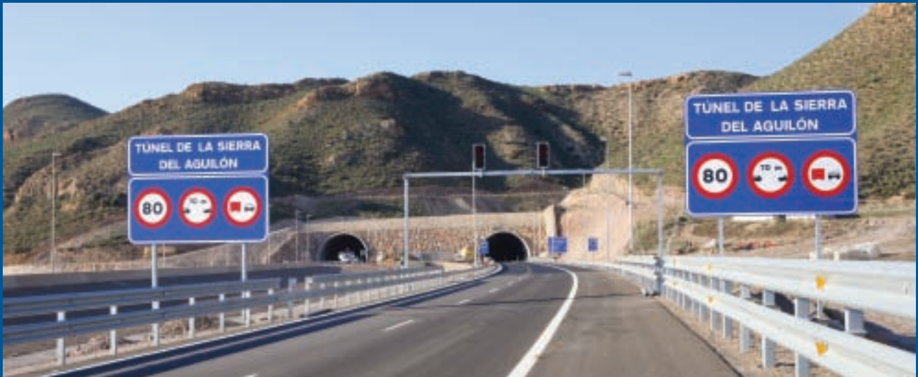
Autopista AP7. Tramo Cartagena-Vera
