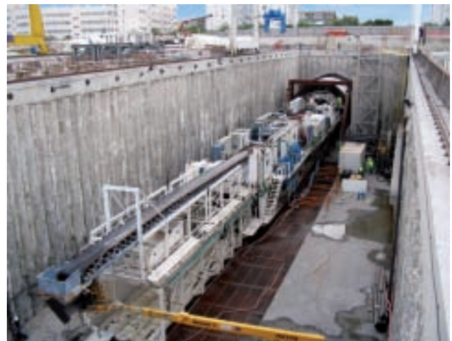
Ampliación línea 7 de Metro de Madrid. Tramo Coslada-San Fernando
