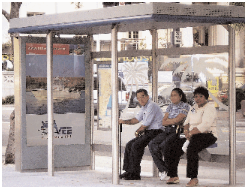
Marquesina solar en Miami. EE.UU.
