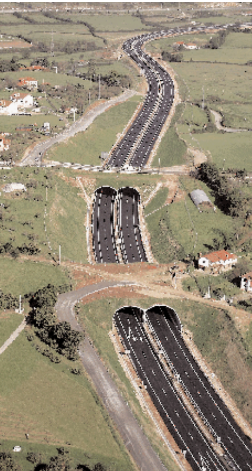
Autovía Minera. Asturias
