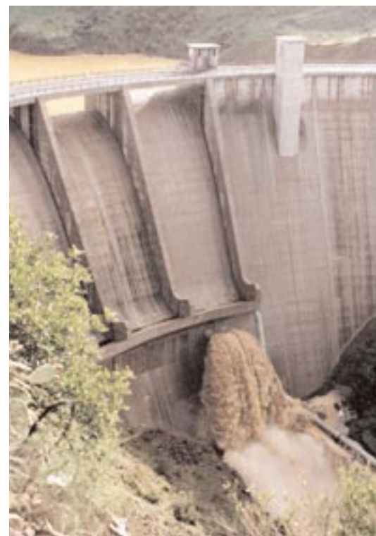
Presa de Casasola. Río Campanillas. Almogía. Málaga
