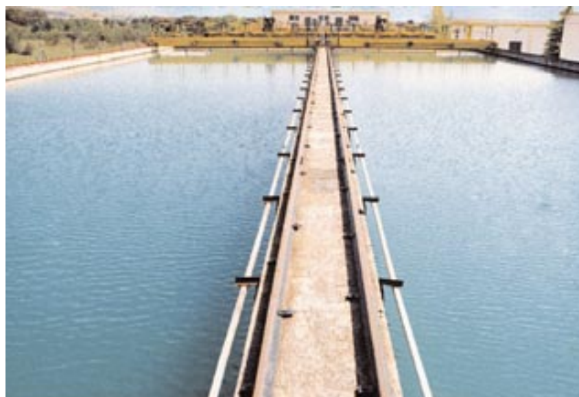
Estación de tratamiento de agua potable de Talavera de la Reina. Toledo
