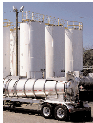
Fábrica de cemento en Keystone. EE.UU.
