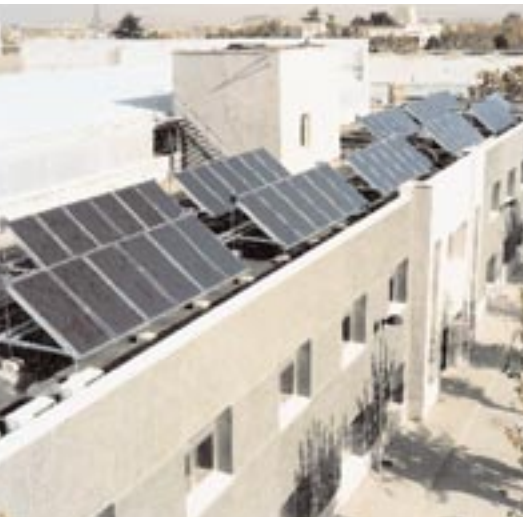
Vista exterior del parque de vehículos de Villaverde. Madrid
