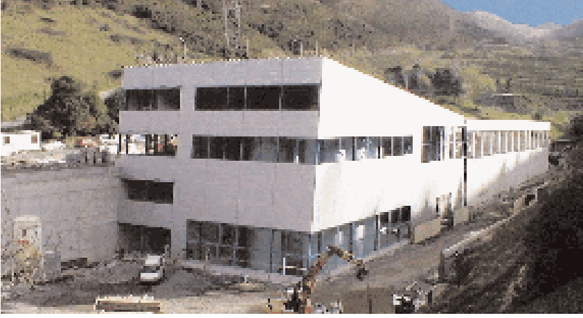
Planta de tratamiento de lixiviados de Artigas. Bilbao
