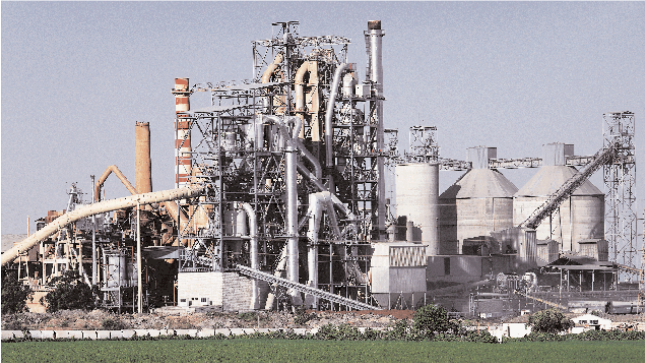
Fábrica de cementos de Alcalá de Guadaíra. Sevilla
