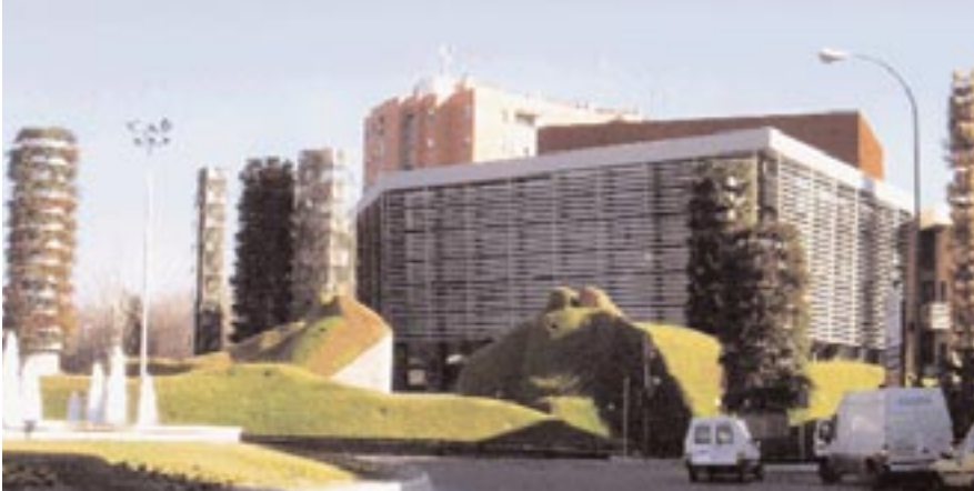
Piscina cubierta Los Rosales. Móstoles. Madrid
