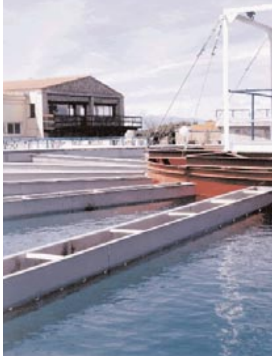
Estación de tratamiento de agua potable. Ávila
