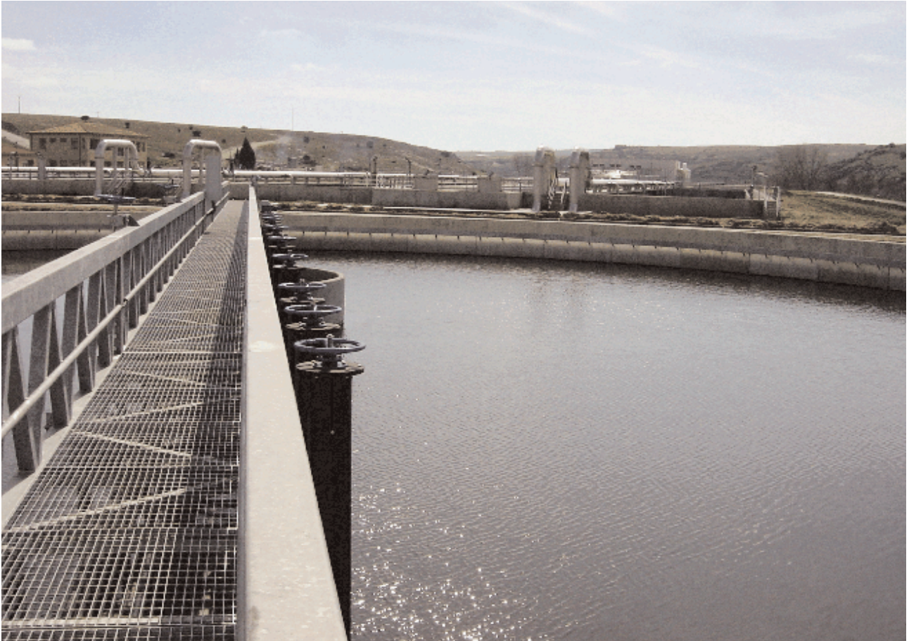
Depuradora de aguas residuales. Salamanca
