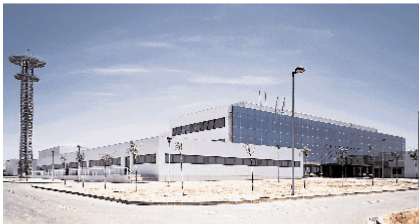
Aeropuerto de Barcelona. Centro de control de Gavá.
