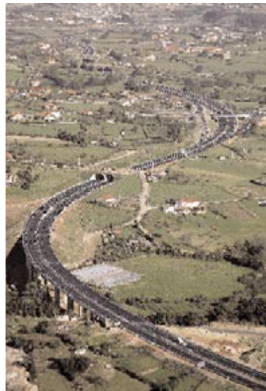
Autovía Minera Asturias
