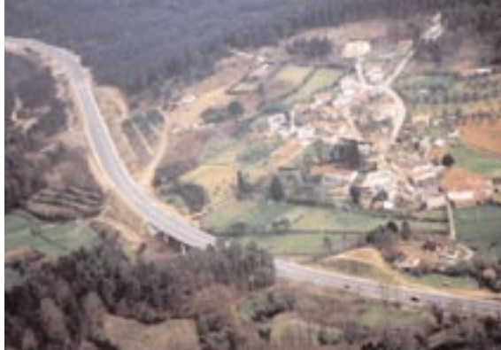
Carretera sur de Lisboa. Viaducto del río Serrazela. Portugal
