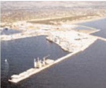
Remodelación del puerto de Castellón
