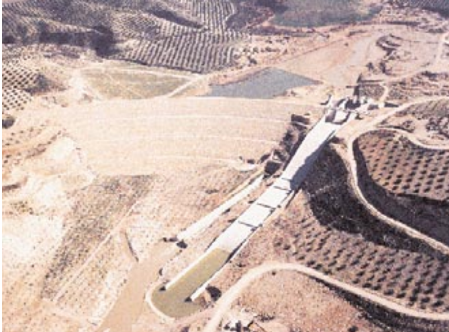
Presa de Vadomojón. Córdoba
