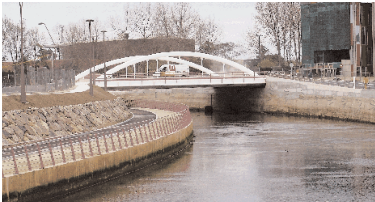
Acondicionamiento del río Piles. Gijón. Asturias
