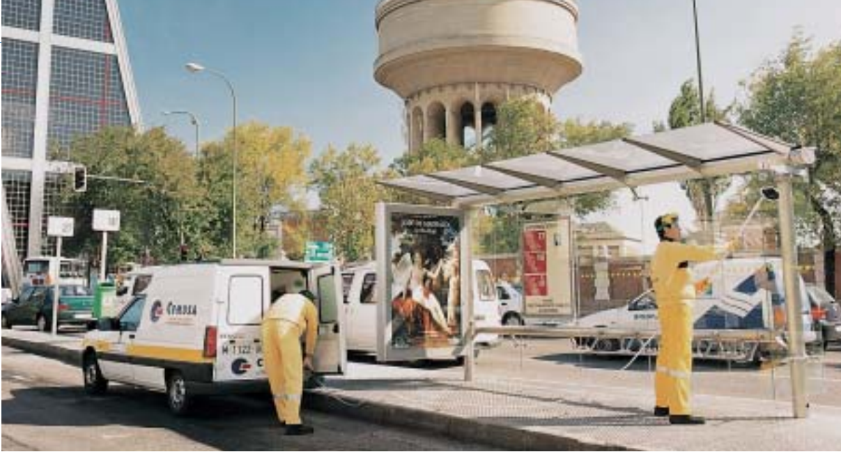
Limpieza y mantenimiento de marquesinas de autobuses. Madrid.
