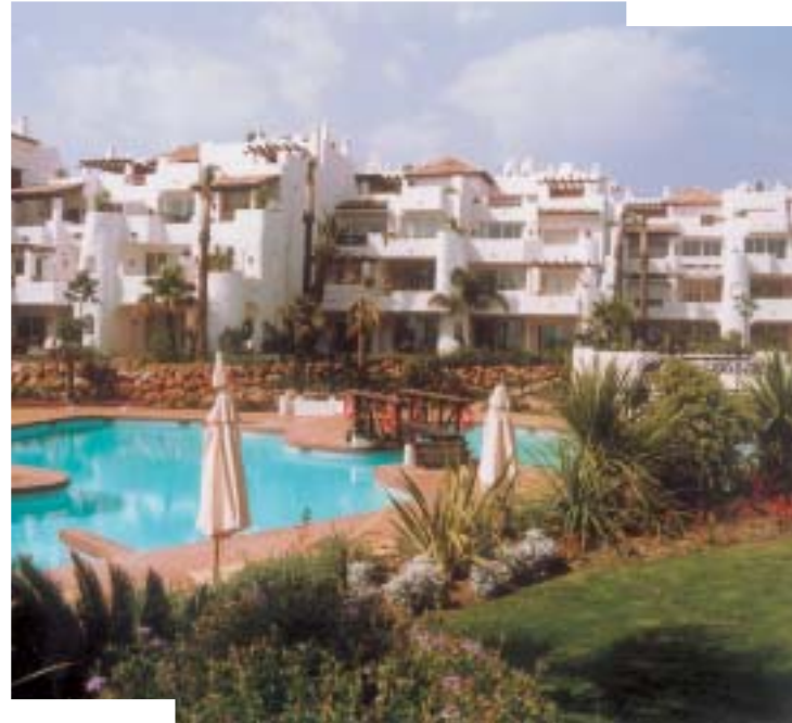
Urbanización Los Monteros Palm Beach. Marbella (Málaga).
