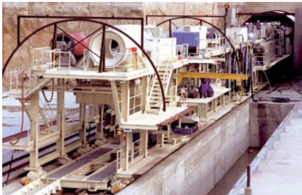
Tuneladora "La Adelantada".
