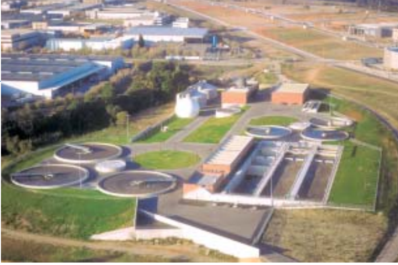
Estación depuradora de aguas residuales de Sabadell (Barcelona).
