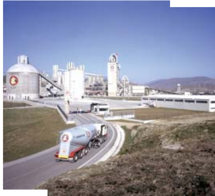
Fábrica de cementos de Mataporquera (Cantabria).
