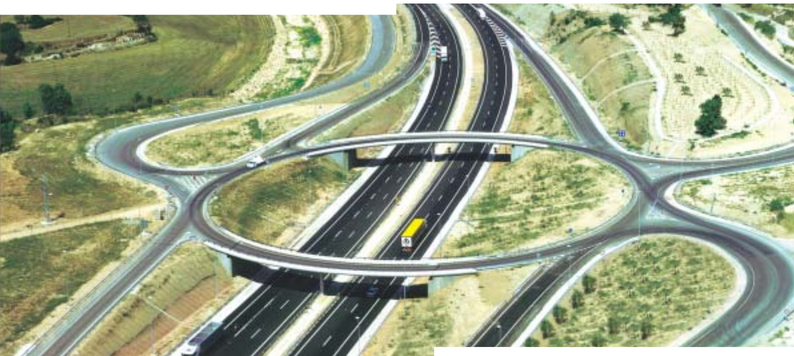
Autovía Lleida-Barcelona. Tramo: Santa María del Camí-Igualada (Barcelona). Enlace en glorieta elevada.
