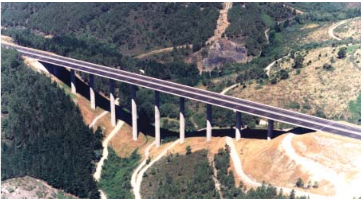
Autovía de la Rías Bajas. Tramo Fumaces-Estivadas. Viaducto de Verín.
