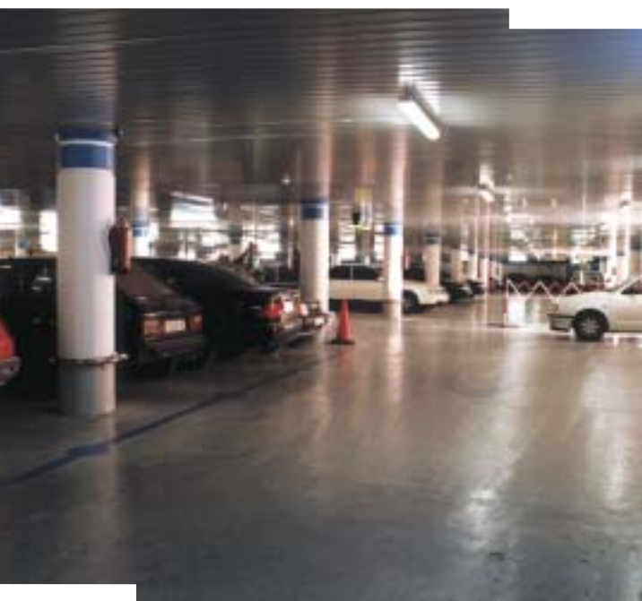
Aparcamiento subterráneo de Granollers (Barcelona).
