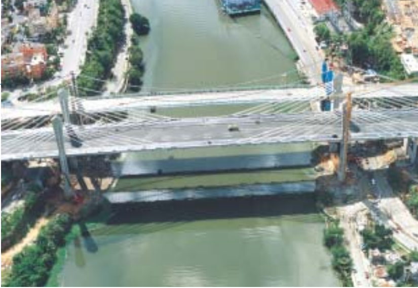
Puente sobre el río Ozama. Santo Domingo (República Dominicana).
