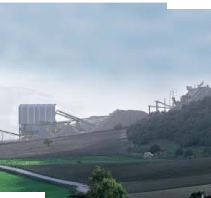
Planta de áridos. Arcos de la Frontera (Cádiz).
