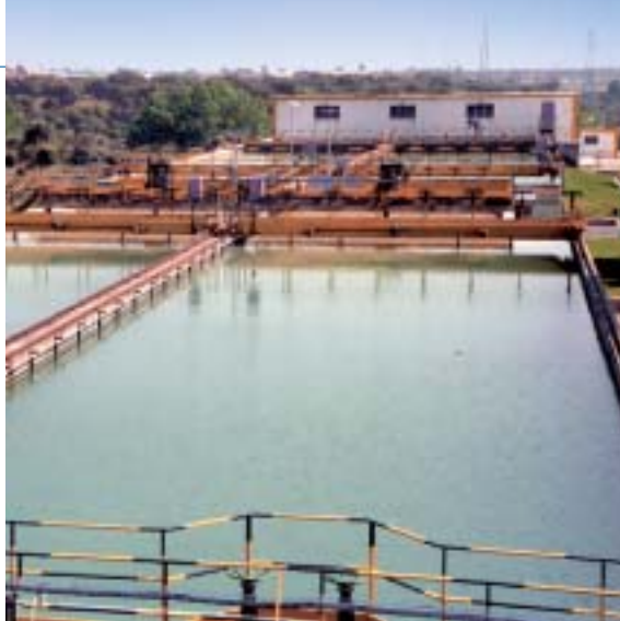
Estación de tratamiento de agua potable de Talavera de la Reina (Toledo).
