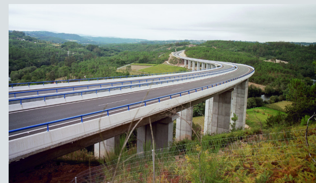
Viaducto sobre el Ulla (autopista gallega)
