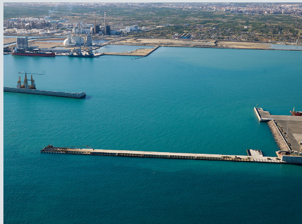
Dique este puerto de Castellón
