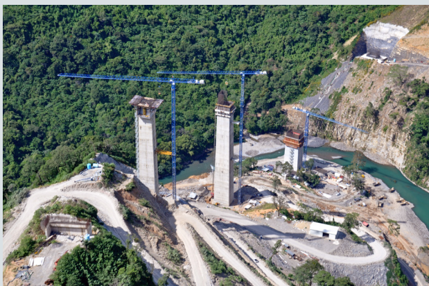
Pilas Viaducto de San Marcos (México)
