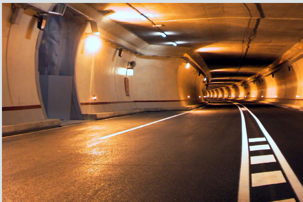
Túnel de Envalira
