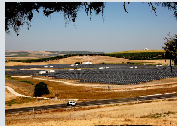
Planta fotovoltaica en Córdoba
