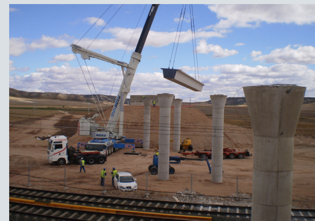
Viaducto Torquemada (Palencia)
