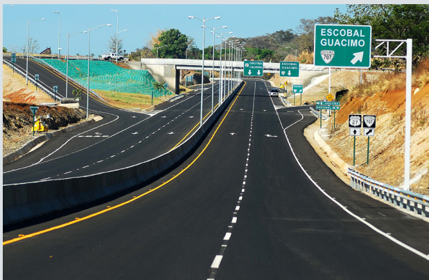
Autopista San José Caldera (Costa Rica)
