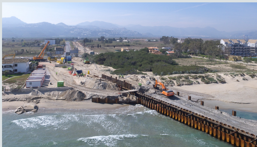
Denia Landfall 3. Gasoducto submarino
