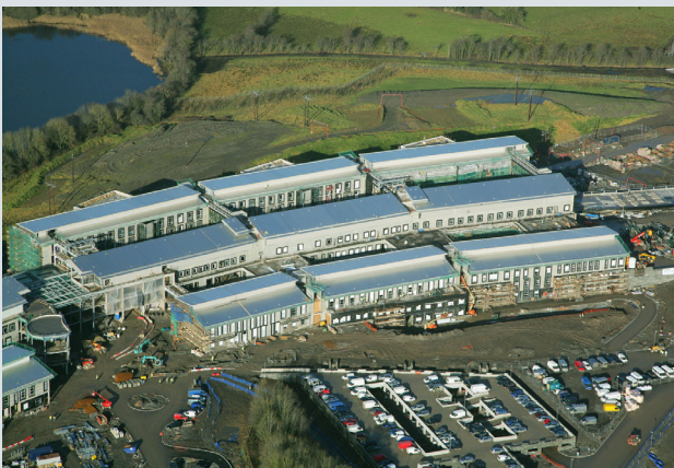
Hospital de Enniskillen (Irlanda del Norte)
