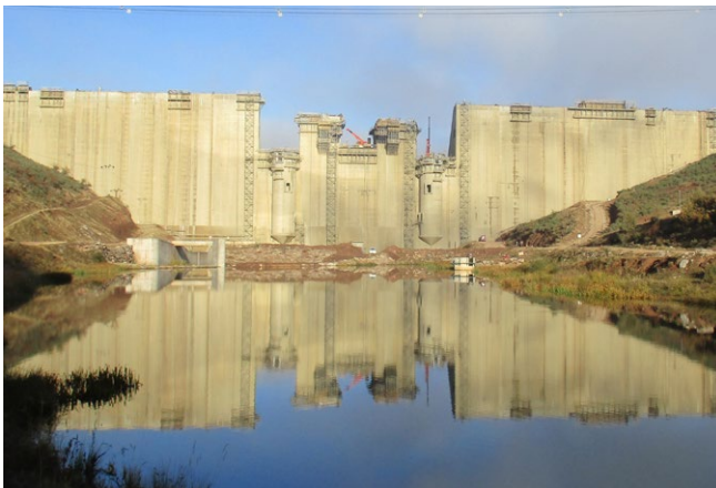
Presa de Castrovido (España).
