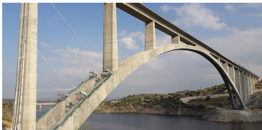
Viaducto de Almonte (España).
