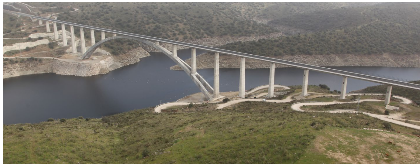
Tramo de AVE Alcántara-Garrovillas (España).
