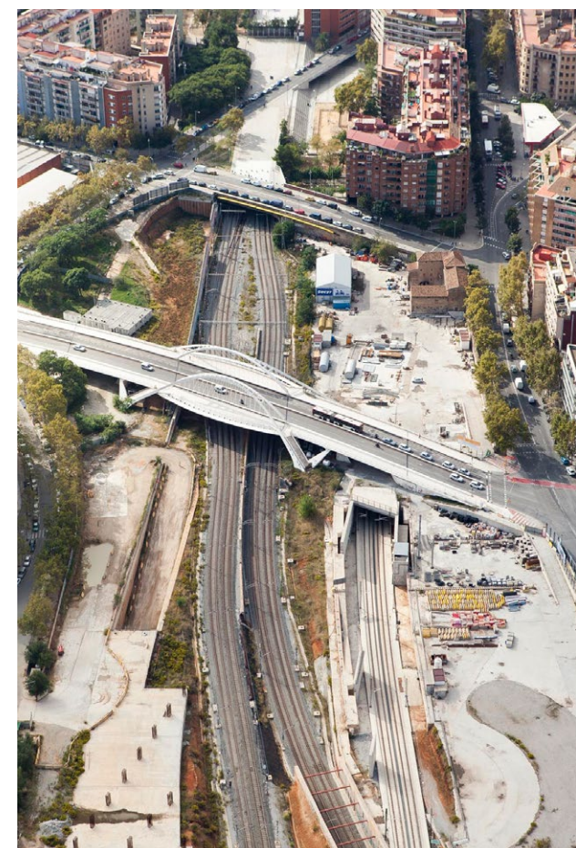
Accesos Estación La Sagrera (España).
