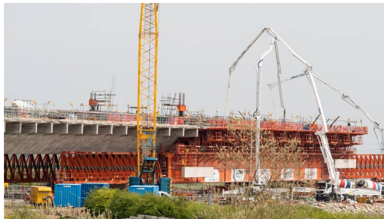
Puente de Mersey (Reino Unido).
