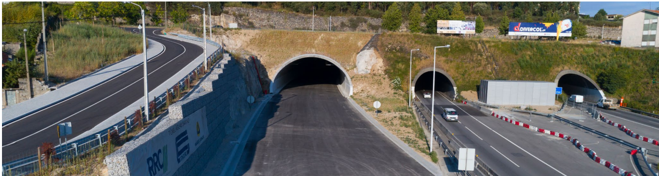
Vista aérea del Túnel Águas Santas, Lisboa, Portugal.
