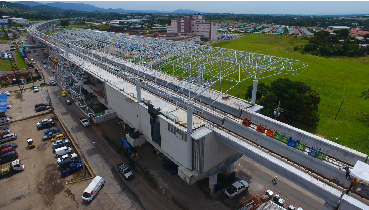
Estación Hospital del Este de la Línea 2 del metro de Panamá.
