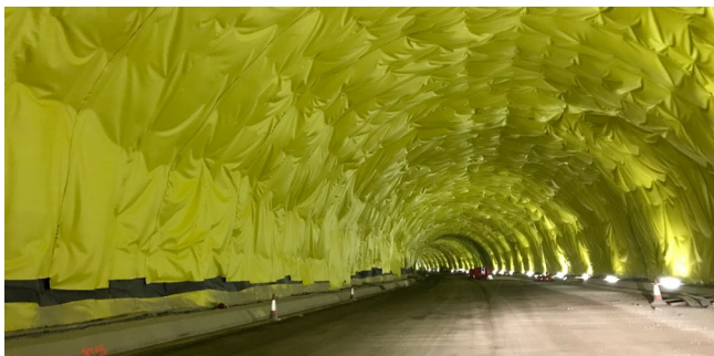
Revestimiento del Túnel de Vallirana, Cataluña, España.
