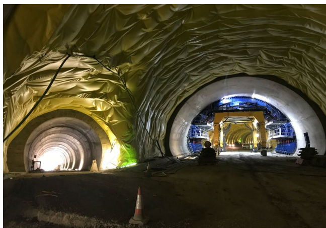
Túnel en la Autovía A-23 de Congosto de Isuela, Huesca, España.
