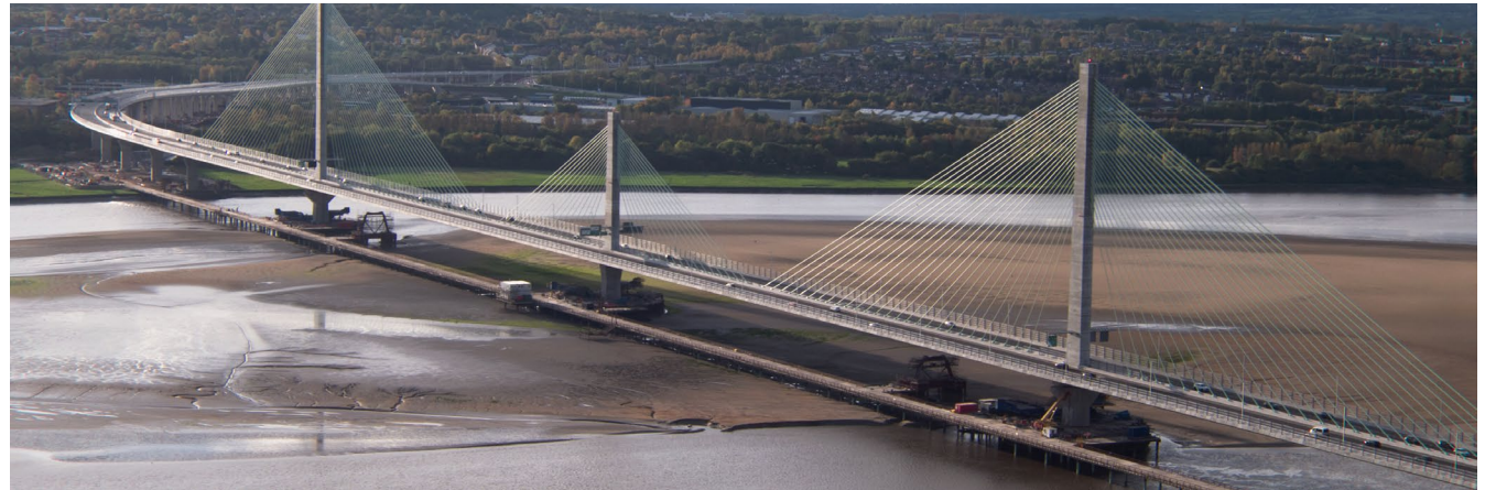
Vista aérea del puente de Mersey, Reino Unido.
