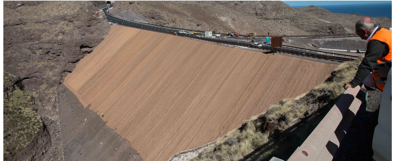
Terraplén cubierto de geomalla
