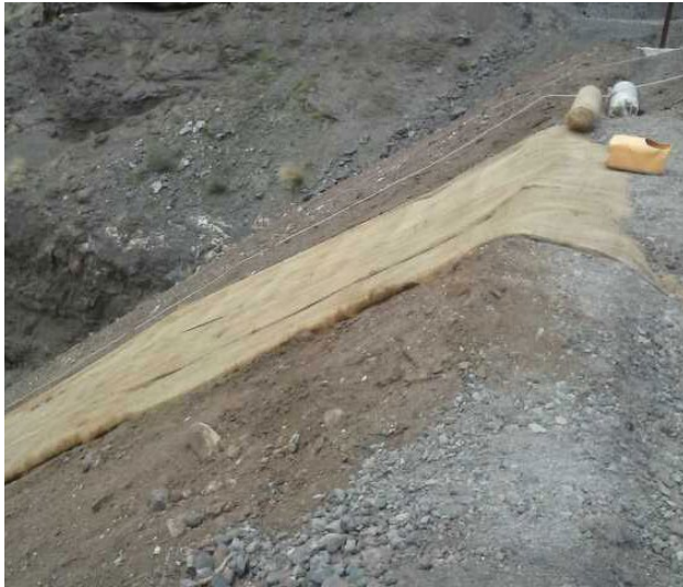
Colocación de los rollos de geotextil
