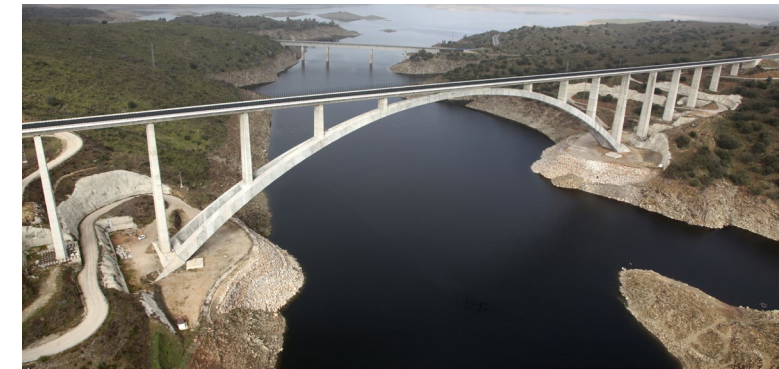
Viaducto de Almonte. Ave Madrid-Extremadura, España.
