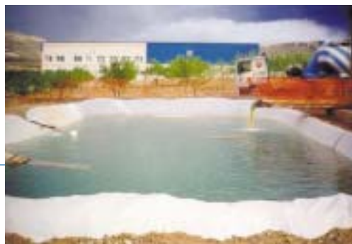
Cada vez es más frecuente en nuestras obras la reutilización de las aguas de lavado para su posterior empleo en la fabricación de hormigón, lo que se hace especialmente necesario en épocas y zonas con escasez de agua, evitando la contaminación que supondría su vertido directo
