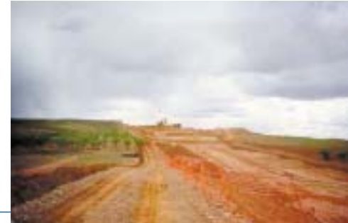
El aumento de las distancias contempladas en el diagrama de masas para compensar las tierras de desmonte y de terraplén, permite grandes ahorros en préstamos e importantes economías en vertederos
