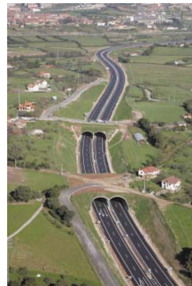
La permeabilidad del territorio frente a infraestructuras lineales se incrementa de manera muy notable con pasos superiores y falsos túneles que permiten mantener, en la medida de lo posible, usos y conexiones preexistentes
