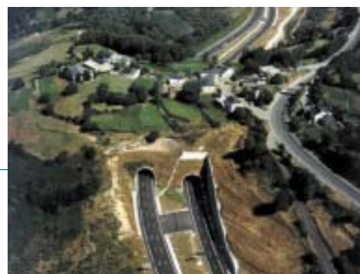
Es sabido que las obras lineales tienen como uno de sus mayores impactos el efecto barrera, pero se dispone de recursos para minimizar dicho impacto, que deben emplearse cuando la sociedad así lo demanda. La permeabilidad territorial a base de pasos inferiores y superiores es aún mayor cuando se trata de túneles que permiten mantener el entorno preexistente
