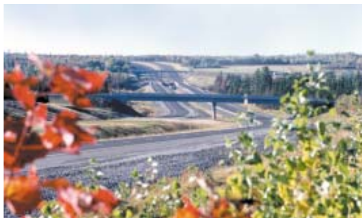
Las obras lineales suponen siempre una herida en el paisaje, pero un diseño correcto, una integración en la morfología, adecuar el trazado a los elementos geomorfológicos existentes disminuye la necesidad de desmonte y terraplén y minimiza impactos ambientales
