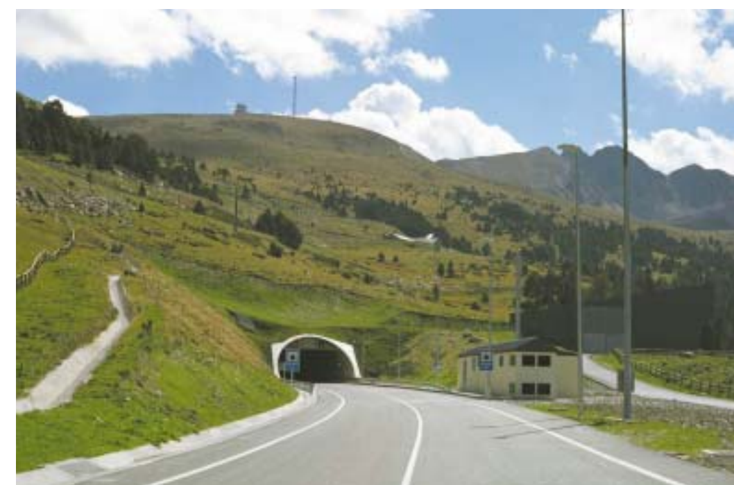
Un adecuado tratamiento del emboquille del túnel mediante envejecimiento artificial de la roca o plantaciones o siembras adecuadas, contribuye a un mayor mimetismo de la obra con su entorno y a un menor impacto paisajístico de la infraestructura
