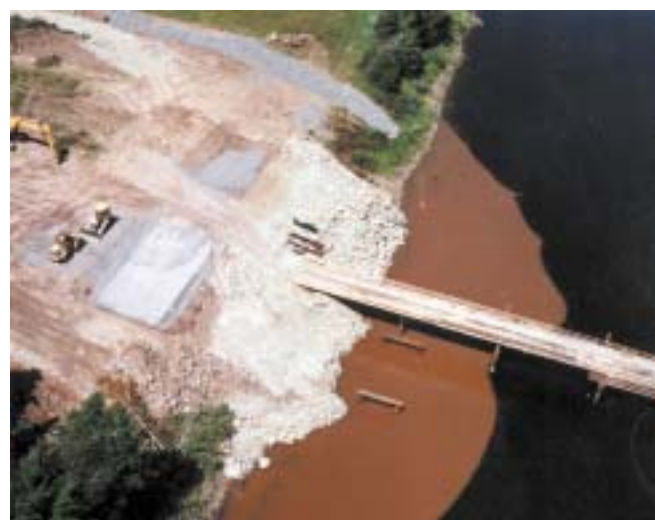
Resulta extraordinariamente eficaz la disposición de geotextiles que actúen como barrera frente a la dispersión de la turbidez del agua provocada por las partículas en suspensión en los trabajos de tierras o para prevenir los arrastres de material suelto
