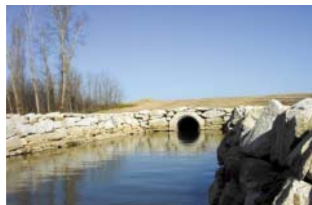
Es necesario buscar la máxima integración de las obras en su entorno, el empleo de materiales locales, las soluciones acordes con el medio, pero siempre con la máxima eficacia y funcionalidad, como en la incorporación a los cauces de los caudales tratados en las depuradoras
