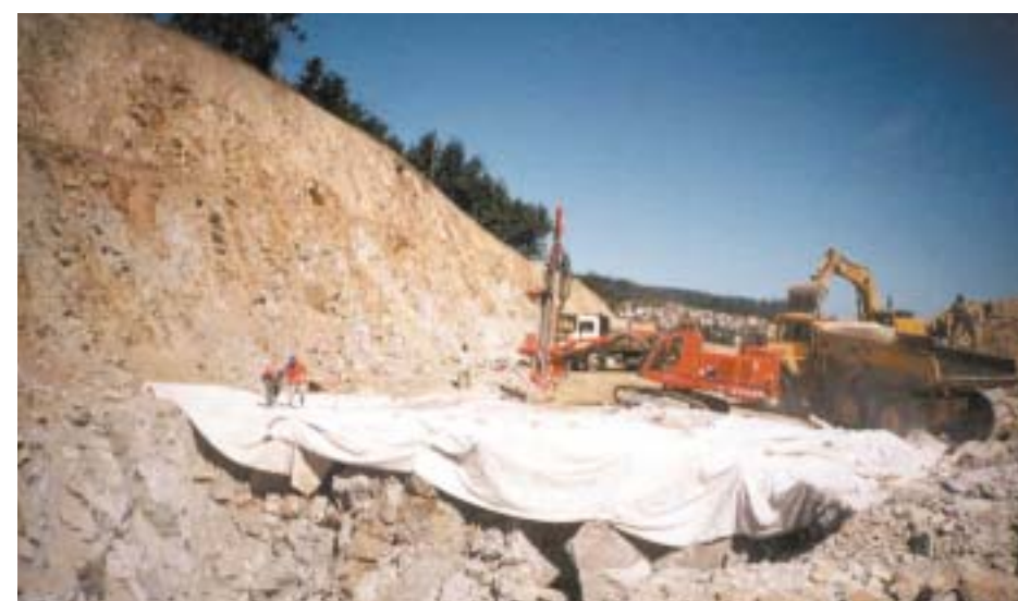
Durante la ejecución de voladuras se genera gran cantidad de polvo y partículas proyectadas que pueden afectar al entorno desde un punto de vista ambiental e incluso de seguridad. La disposición de mantas geotextiles previene eficazmente este impacto
