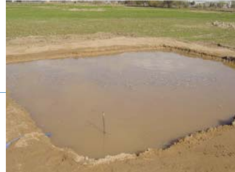
Las balsas de decantación disminuyen extraordinariamente la turbidez final del vertido, el aporte de finos a los cauces y la erosión, y no supone una inversión importante. Se trata, como tantas otras veces, más de una cuestión de voluntad y concienciación que de presupuesto
