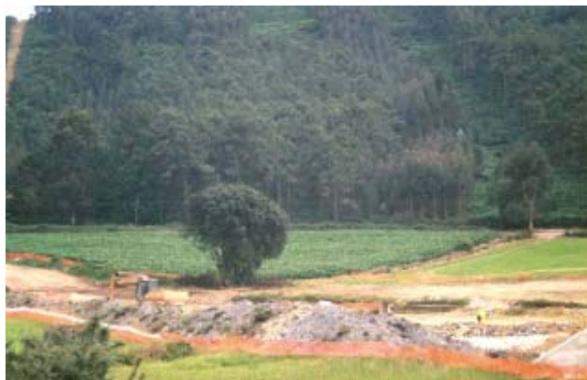
La delimitación con barreras de las áreas que deben ocuparse resulta fundamental para evitar un deterioro innecesario de las zonas colindantes de valor natural que, de otro modo, podrían ocuparse y degradarse por paso de personal o de maquinaria
