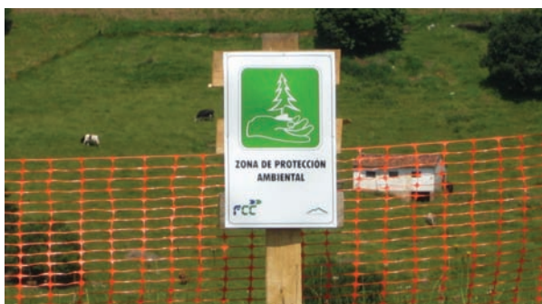
En la práctica totalidad de nuestras obras se despliega una señalización ambiental que ayuda a poner orden, informa y conciencia al personal y facilita la comprensión y el cumplimiento del comportamiento ambiental por parte de todos los implicados
