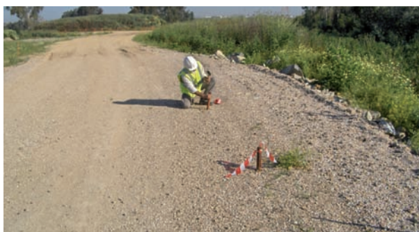
La realización de un estudio previo al inicio de las obras para determinar las principales especies animales y corredores faunísticos de la zona, nos permite identificar en cada momento de la obra los daños que ésta puede ocasionar tanto en dichas especies, como en sus hábitats y actuar en consecuencia.
