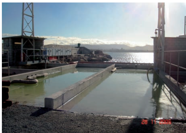
Con las balsas de decantación conseguimos, por una parte, la sedimentación de los sólidos en suspensión de las aguas procedentes de las distintas actividades de la obra y, por otra, la minimización del posible riesgo de un eventual derrame de sustancias contaminantes o peligrosas.
