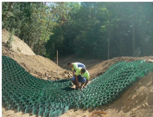
La colocación de geoceldas a la hora de emprender la restauración de un cauce posibilita la revegetación de los taludes del mismo, ya que permite el control de la erosión y el establecimiento de vegetación.
