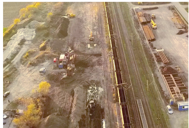
Superficies autorizadas para ejecutar la descontaminación de balasto en lugares cercanos a las vías.
