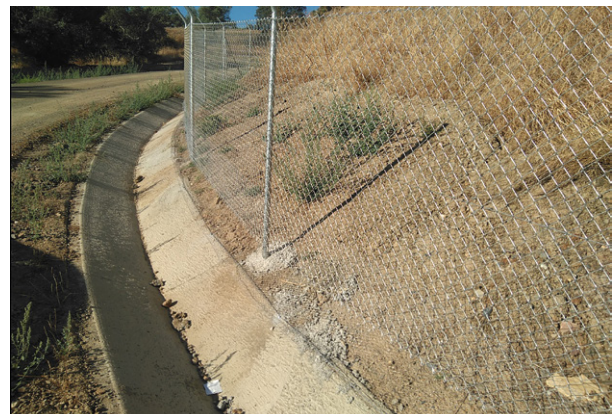
Vallado perimetral para evitar el paso de pequeños mamíferos.
