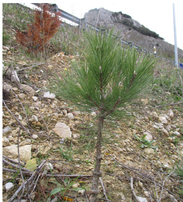
Árboles y arbustos sembrados en el talud.
