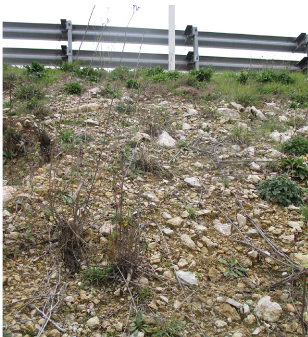
Tierra seca con pérdida de suelo
