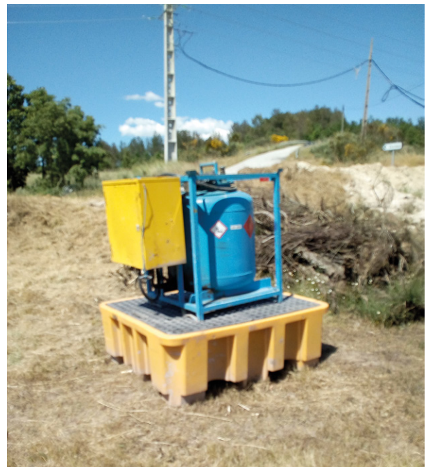
Cubeta de contención de derrames.
