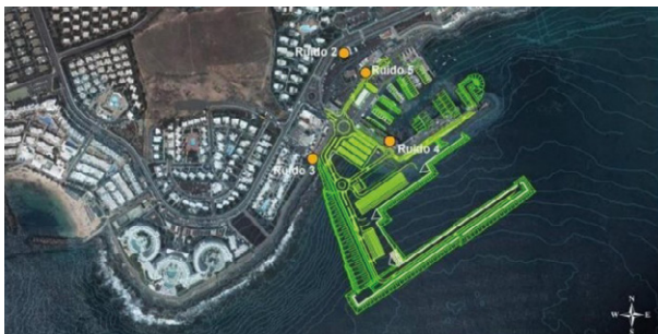
Puntos de muestreo de ruido cercanos a la obra.
