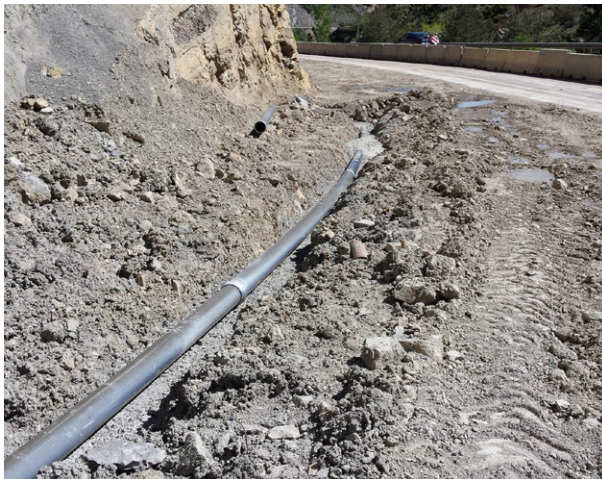
El vertido resultante de las perforaciones y las surgencias se ha canalizado hasta las balsas de decantación.
