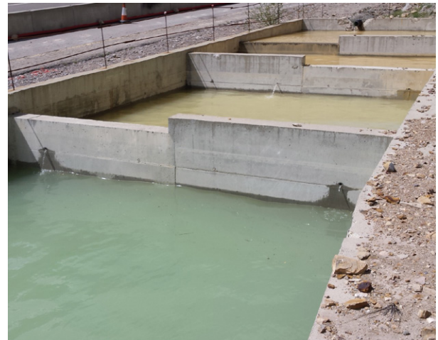
Las balsas secuenciadas permiten decantar los sólidos en suspensión antes de verter las aguas al río.
