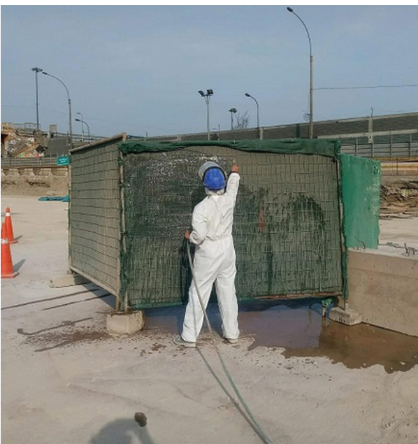
Un operario humedece la malla raschel alrededor de la zona de corte del hormigón.
