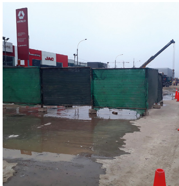
Los recintos de malla se orientan fácilmente según la dirección del viento para impedir la dispersión de las partículas.
