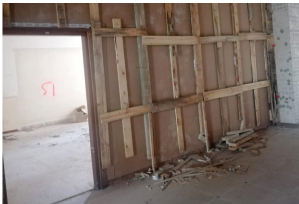
Bastidor que sujeta la protección de geotextil para el paño del mural que ha permanecido en el edificio.
