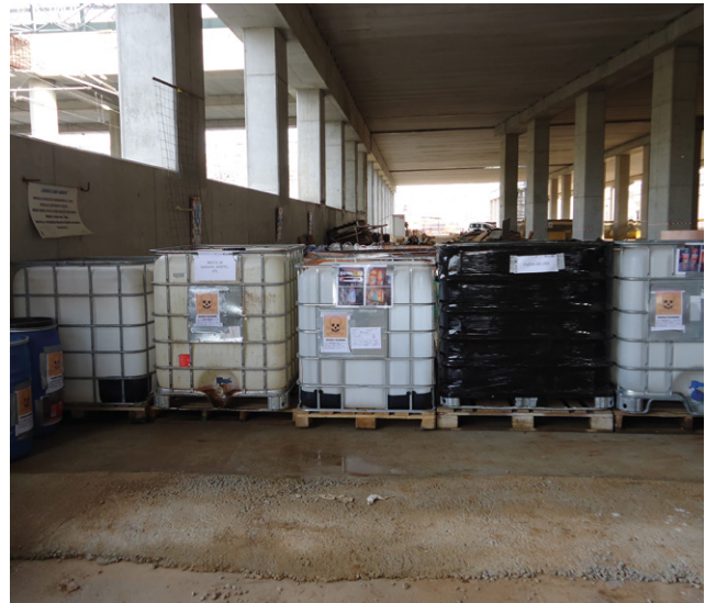
Para facilitar la correcta clasificación de los residuos peligrosos, todos los contenedores están identificados con el nombre, código y pictograma de peligrosidad del residuo.
