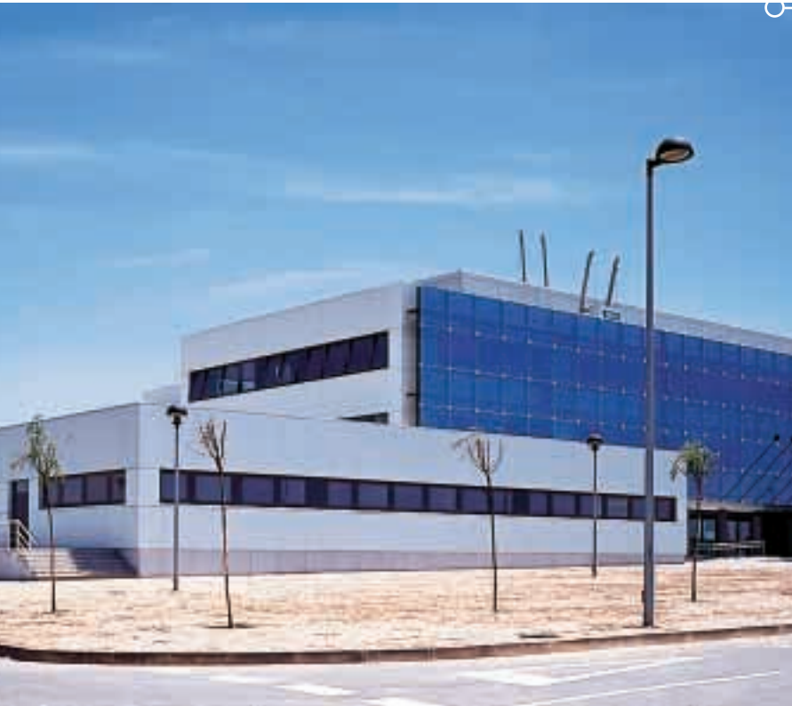
CENTRO DE CONTROL de Tránsito Aéreo de Gavá, en Barcelona, de la Delegación Cataluña Edificación I (Zona III).
