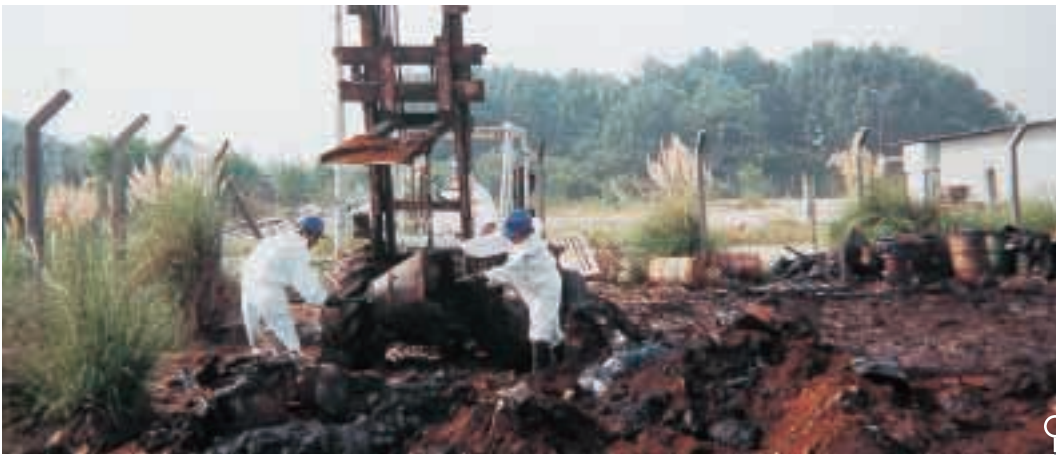
TRABAJOS de recuperación de una ruina industrial.
