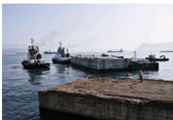
Operación de traslado del cajón a su ubicación definitiva.
