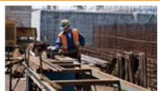
Recorremos el dique flotante Mar de Aneto, en Algeciras (Cádiz)
