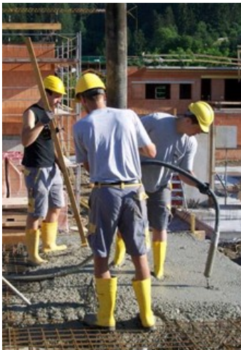
Se van a construir 26 casas nuevas como parte de una aldea familiar.
