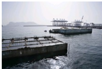
Cajones fabricados para la construcción del muelle.
