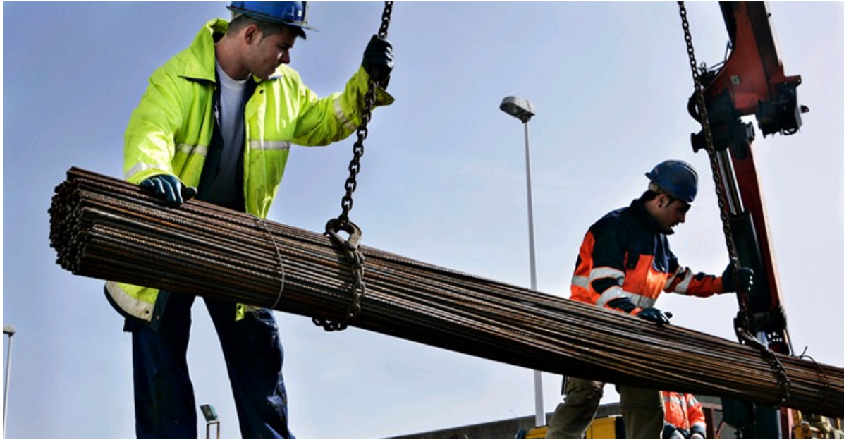
Operarios en el parque de ferralla.
